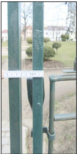
FOTOPOHLED V M 1:5 NA HLAVNÍ KRAJNÍ RÁMOVÝ ZÁMEČNICKÝ PROFIL 24/24mm - PATRNÁ KOROZE RÁMU POD BARVOU, VZDÁLENOST OD RÁMU KŘÍDLA BRÁNY A UCHYCENÍ PLOTOVÉHO RÁMU.
