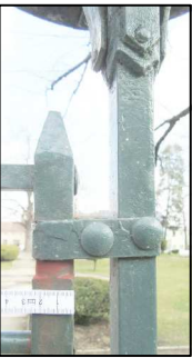
FOTOPOHLED V M 1:5 NA HLAVNÍ KRAJNÍ RÁMOVÝ ZÁMEČNICKÝ PROFIL 24/24mm - PATRNÁ KOROZE RÁMU POD BARVOU, VZDÁLENOST OD RÁMU KŘÍDLA BRÁNY A UCHYCENÍ PLOTOVÉHO RÁMU.
