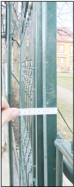
FOTOPOHLED V M 1:5 NA HLAVNÍ KRAJNÍ RÁMOVÝ ZÁMEČNICKÝ PROFIL 24/24mm - PATRNÁ KOROZE RÁMU POD BARVOU. BOČNÍ ROZMĚR A KONSTRUKČNÍ NÁVAZNOSTI.
