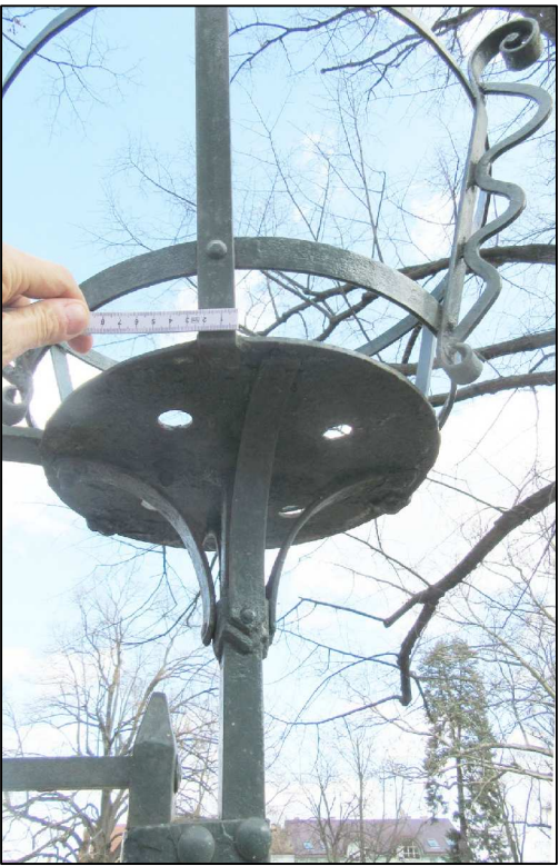
FOTOPOHLED NA LEVÉ KŘÍDLO VSTUPNÍ BRÁNY DO ROZÁRIA M 1:10 POHLED Z ULICE. NEJSTARŠÍ BRÁNA PARKU.NEPŮVODNÍ ZELENÁ BARVA, POKŘÍVENÉ JEDNOTLIVÉ DÍLY BRÁNY, KOROZE VE SPODNÍ ČÁSTI BRÁNY A U NAMÁHANÝCH SPOJŮ. FOTOGRAMETRICKÉ ZAMĚŘENÍ POMOCÍ METRU. ROZMĚR KŘÍDLA BRÁNY 1,3m x 2,4m.
